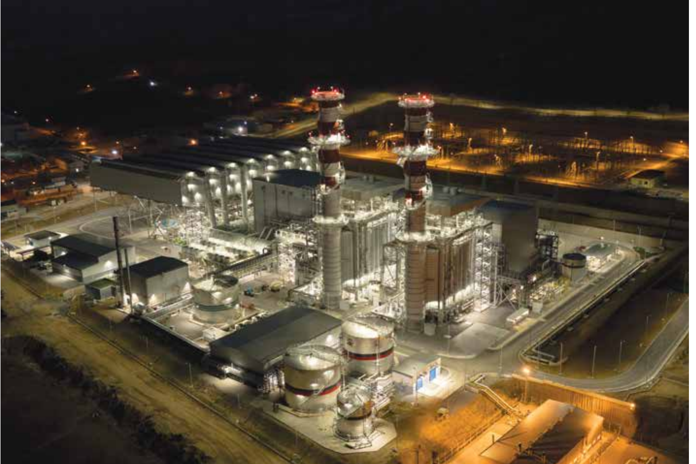
840 MW İç Anadolu Kombine Çevrim Doğalgaz Güç Santrali-Kırıkkale, Gama İnşaat A.Ş.
